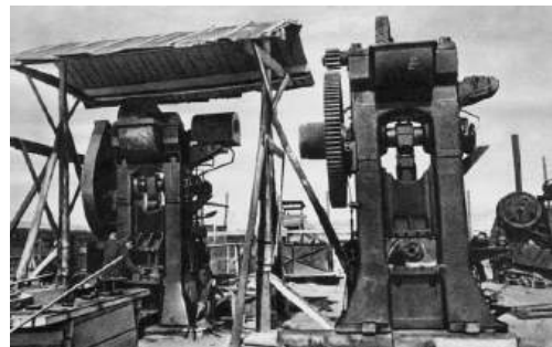
Монтаж оборудования на эвакуированном заводе. Казахстан. 1942 г.
