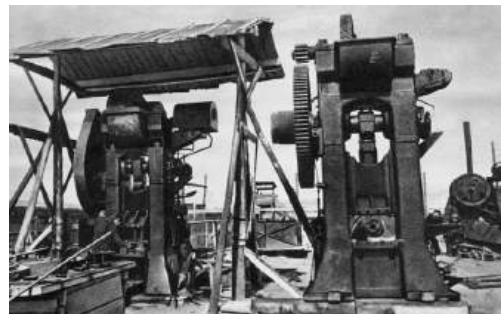
Монтаж оборудования на эвакуированном заводе. Казахстан. 1942 г.
