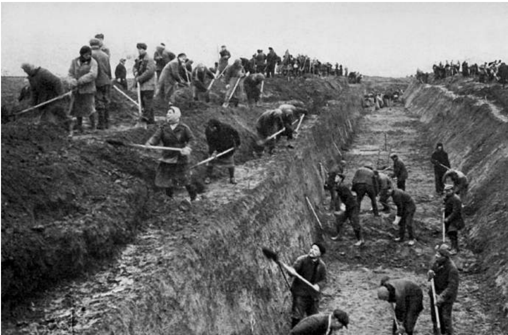
Строительство оборонительных сооружений под Москвой. Осень 1941 г.
