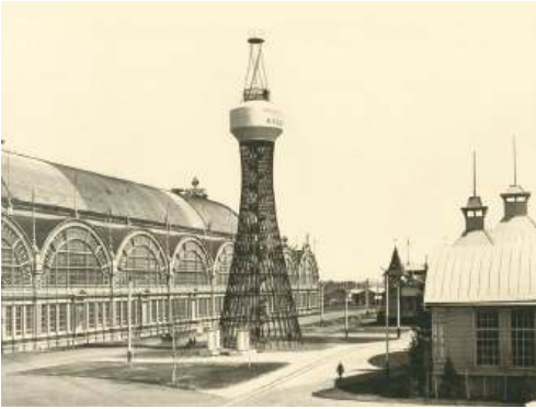
Гиперboloидная башня. Инженер В. Г. Шухов
