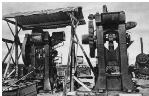
Монтаж оборудования на эвакуированном заводе. Казахстан. 1942 г.
